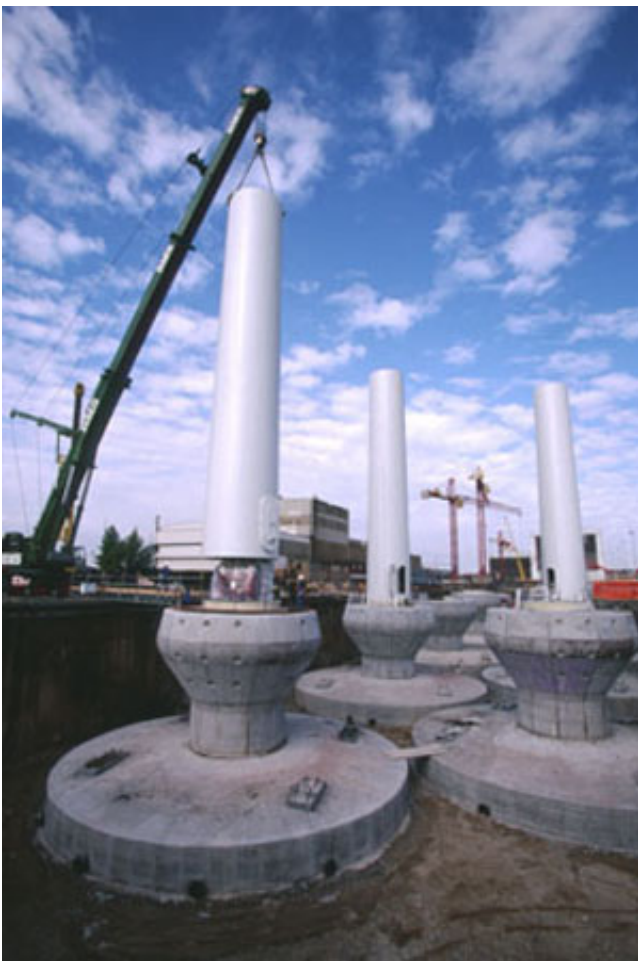
Tillverkning av fundament och torn för danska projektet Middelgrund. De vinglasforade fundamenten har en isbrytande effekt.
