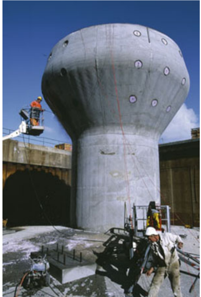
Tillverkning av fundament och torn för danska projektet Middelgrund. De vinglasforade fundamenten har en isbrytande effekt.
