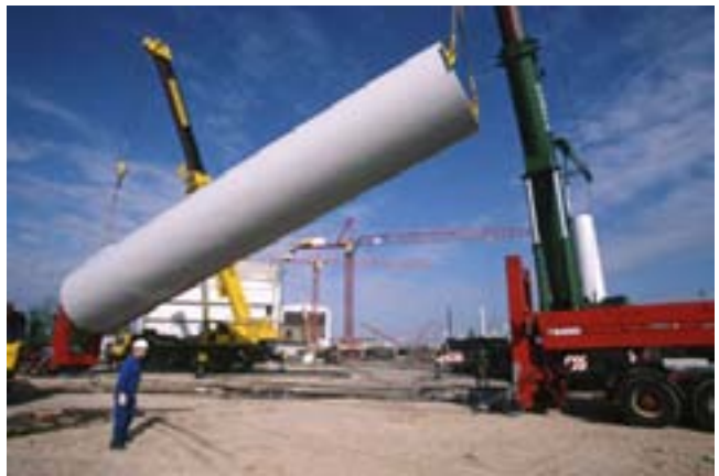
Tillverkning av fundament och torn för danska projektet Middelgrund. De vinglasforade fundamenten har en isbrytande effekt.
